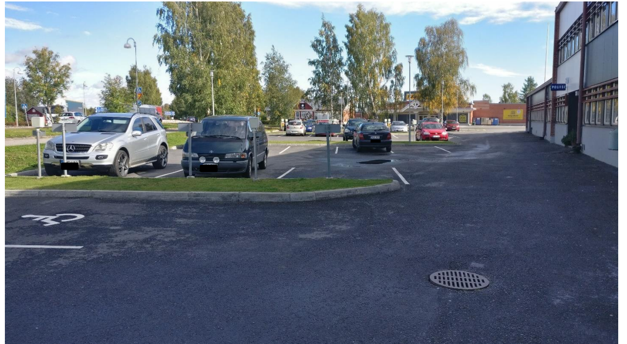
Näkymä Pajalan palvelukeskuksen edessä olevalle pysäköintialueelle itään päin.
